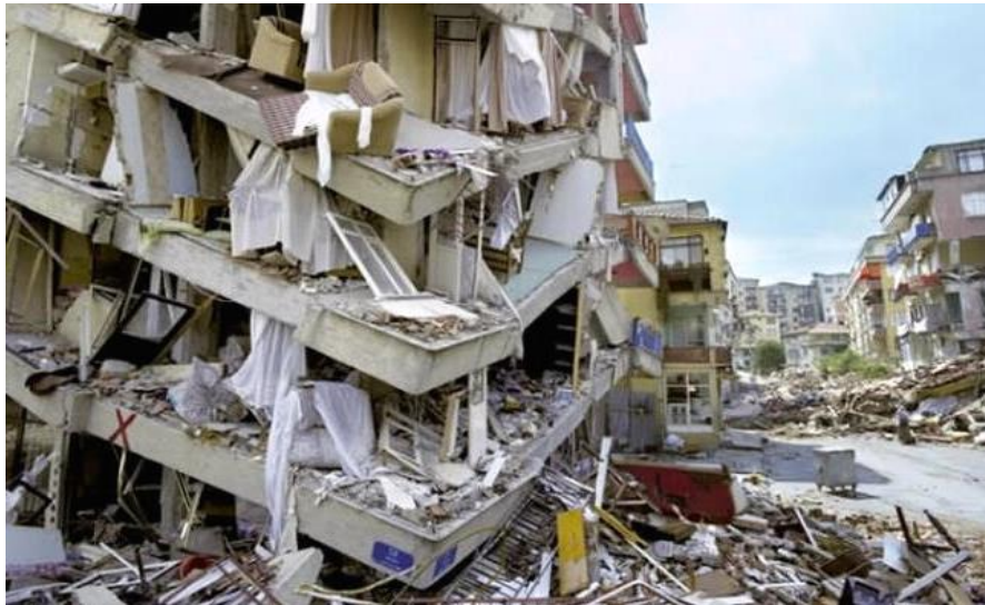
Resim 1. Elazığ-Sivrice depreminde, depreme dayanıklı bina standardına uymadığı için yıkılan ve zarar gören binalar.
