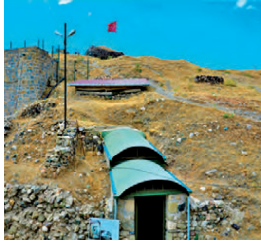
Foto.4: Harput İç Kaledeki Su Sarnıcı (Zindan) dıştan genel görünüm
