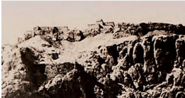
Foto.3: Harput İç Kaledeki konutun güneyden görünümü (1900)
