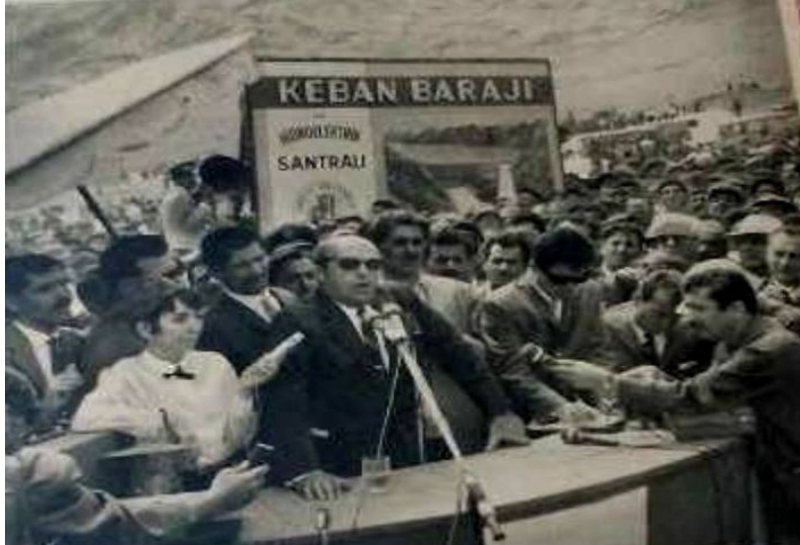
1966, Başbakan Süleyman Demirel, 1965 yılında temeli atılan Keban Barajı’nda
