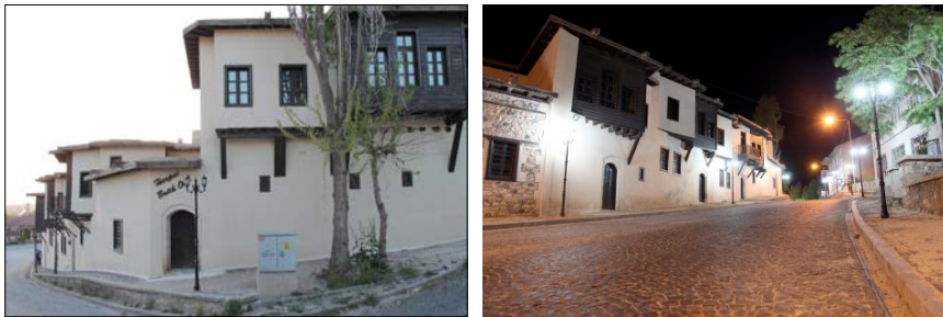
Resim 9: Harput'un Dağ Kapı Restorasyon Sonrası Görünümü [2]
