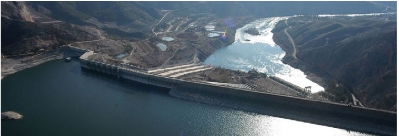
"Keban Barajı, Elâzığ ilinin Keban ilçesinde, Fırat Nehri üzerinde, 1965-1975 yılları arasında inşa edilmiş olan elektrik enerjisi üretimi amaçlı barajdır."
