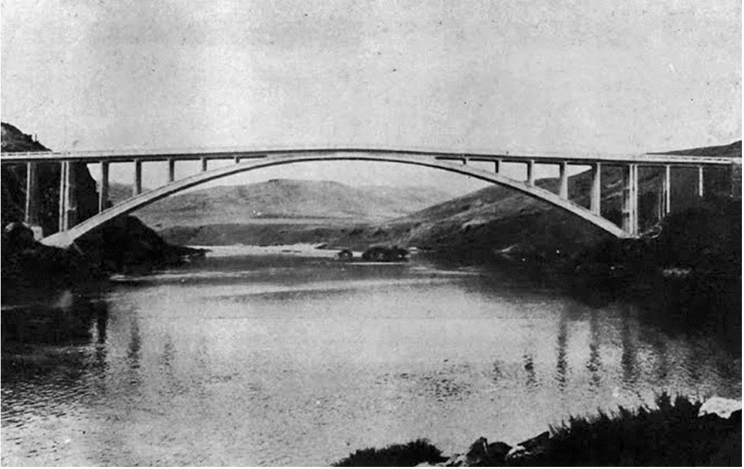
Pertek Köprüsü'nün Baraj Suları Altında Kalmadan Önceki Görünüşü
