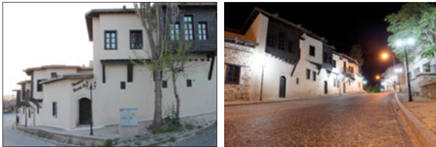
Resim 9: Harput'un Dağ Kapı Restorasyon Sonrası Görünümü [2]
